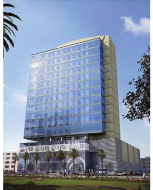
تصميم مبنى الإدارة العامة الجديد (تحت الإنشاء) - جبل عمان
